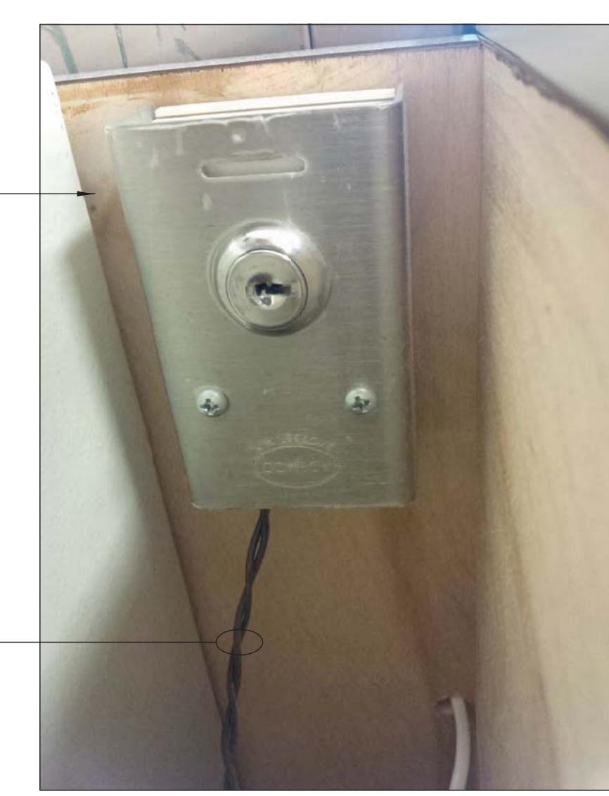
PHOTO: PANIC ALARM FA SCALE: NONE
